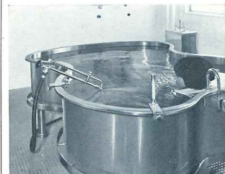
浴中圧注ノズルでの浴中圧注です。ノズルは自由に移動できます。
